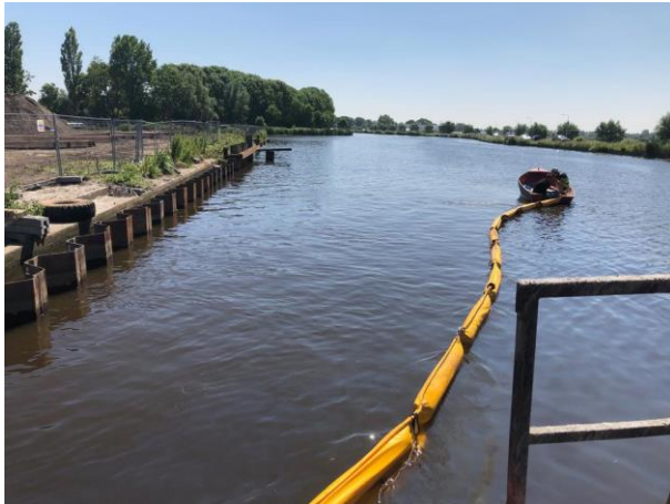
Figuur 1: Aanbrengen oliescherm met Boot (links), Oliescherm aanwezig om werkgebied (rechts)
